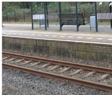
Schanskorven gevuld met ironstone in roesttint en aangevuld met hergebruikt metselwerk keerwanden
