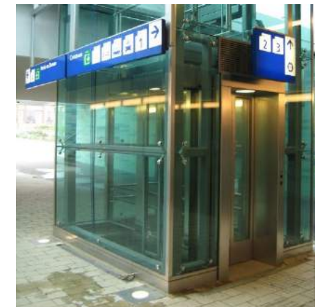
Deuren lift terugliggend uitgevoerd
